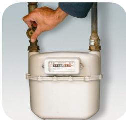
C'est une bonne habitude de fermer le robinet du compteur ou le robinet du circuit d'alimentation en gaz de l'habitation lorsque l'on n'utilise pas les appareils à gaz. Cette opération doit être effectuée en cas d'absence à la maison, même de brève durée.
