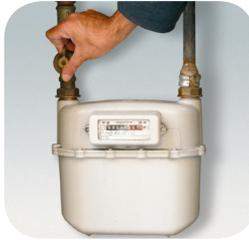
Es una buena costumbre cerrar el grifo del contador o el de entrada de alimentación de la tubería de gas en los hogares cuando no se utilizan aparatos de gas.
